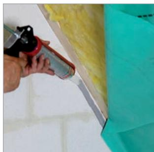
Однокомпонентный клей-герметик Pasto® имеет мягкоэластичную консистенцию и может многосторонне применяться без грунтовки во внутренней и внешней зонах. Клей-герметик обладает высокой герметизирующей способностью и соответствует требованиям стандарта DIN 4108, часть 7.
