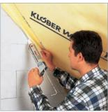
Благодаря специальному покрытию пленка "Wallint® 10 есо" предотвращает проникновение имеющейся в помещении влажности в изоляцию, но позволяет одновременно выводить из помещения влагу, содержащуюся в дереве и встроенных элементах.
